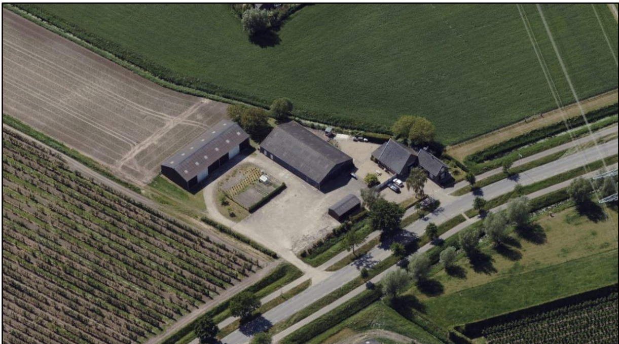
Figuur 3: Aanzicht plangebied in vogelvlucht vanuit oostelijke richting. Bron: Cyclomedia Technology BV, 2021.
