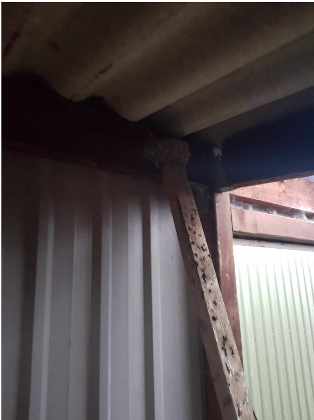
Huis- of boerenwaluwnestje op houten paal in bijgebouw 3 , vanwege openheid echter oninteressant voor vleermuizen. Bijgebouw 3 is een erg klein schuurtje (t.o.v. bijgebouw 1 en 2)
