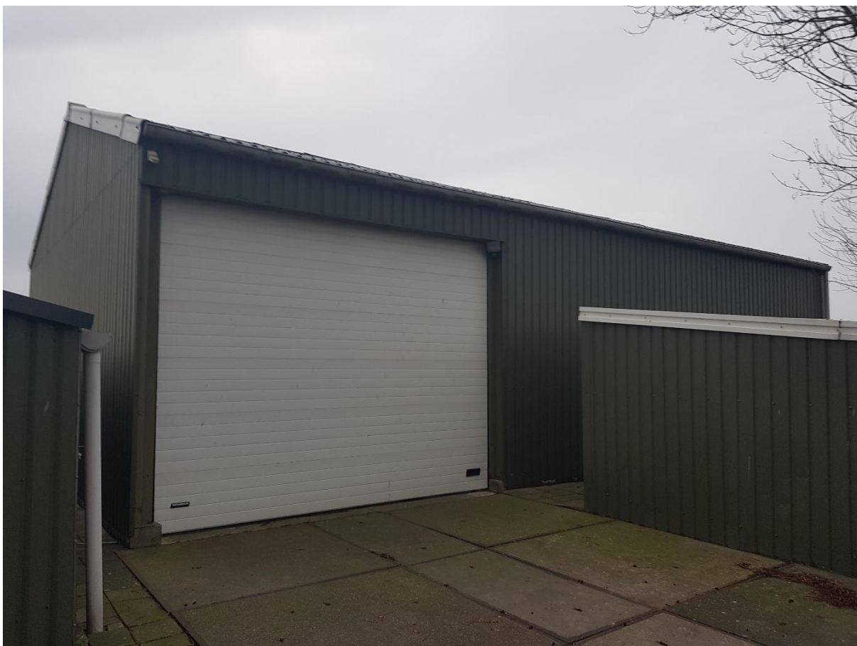
Bijgebouw 2 bestaat bijna geheel uit damwanden. Bijgebouw 3 (rechts) ook muren van damwand, maar dak van asbest.
