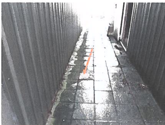
Tegelpad waarin de boringen en de peilbuis t.b.v. het grondwateronderzoek zijn geplaatst. Geplaatste peilbuis (→)
