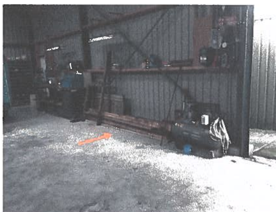
Aangewezen voormalige ligplaats bovengrondse dieselolietank op vloeistofdichte vloer in loods.
