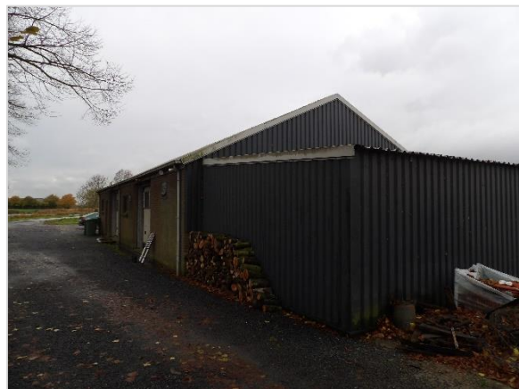
Foto 2: Loods bestemd voor oprichten van een kleinschalige dag- en avondhorecavoorziening.
