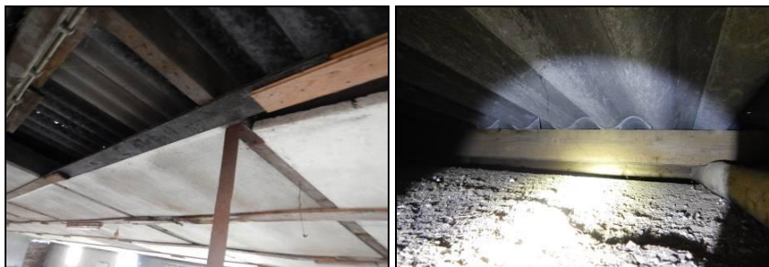
Figuur 7. Onderzochte ruimte achter isolatiemateriaal in de schuren.
