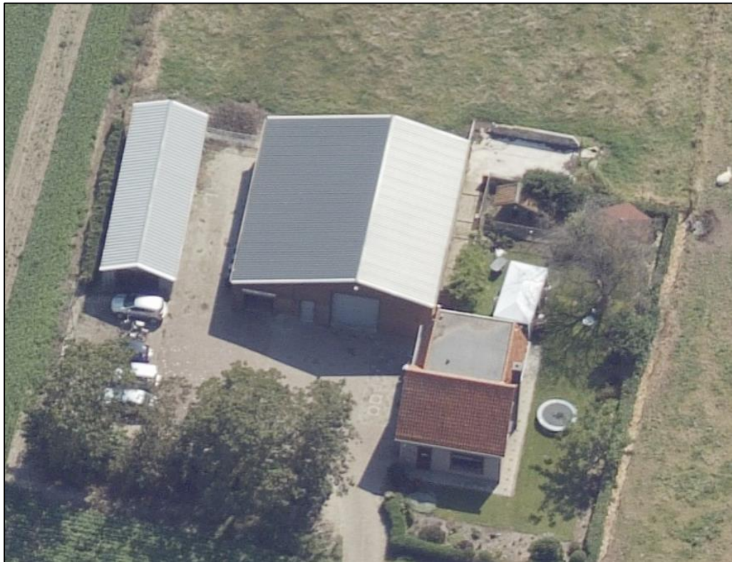
Aanzicht aanwezige bebouwing binnen het plangebied. Bron: cyclomedia, 2020.
