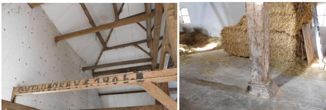
Figuur 10 - (links) schildering op een balk, aangebracht door de aannemer G. v. Tillo in 1906; (rechts) staander op gemetselde stiep.
