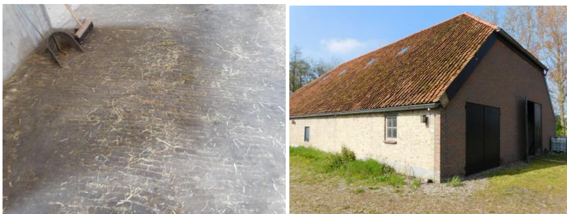
Figuur 11- (links) Een gedeelte van de vloer in de schuur bevat nog de oorspronkelijke bakstenen verharding; (rechts) de achtergevel van de schuur is waarschijnlijk vernieuwd na de watersnoodramp van 1953.
