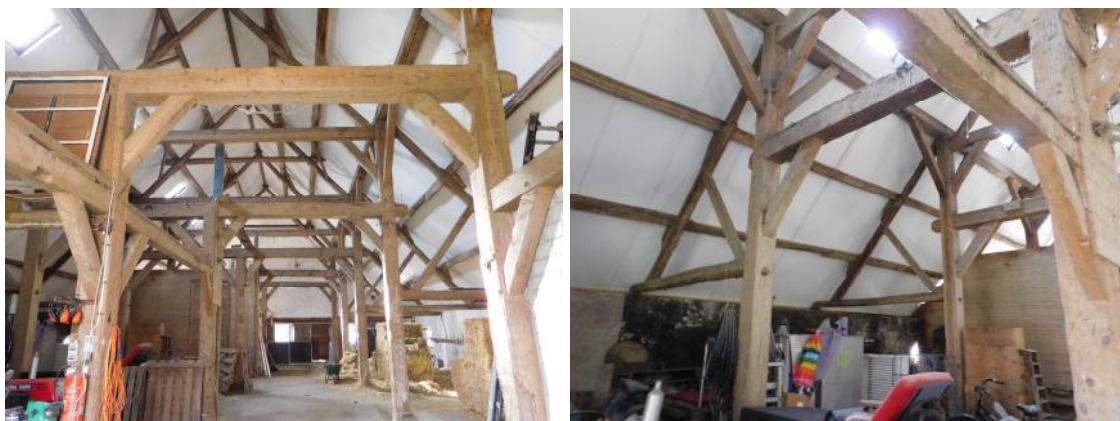
Figuur 9 - interieur van de grote schuur; opvallend is houten draagconstructie (links overzicht draagconstructie, rechts detail).
