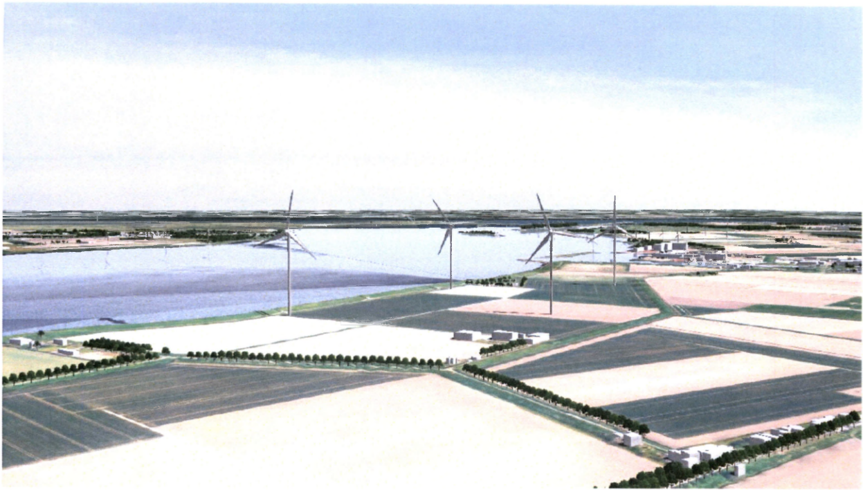
Impressie van de clusteropstelling met een rotordiameter 140 meter. Deze impressie sluit aan bij de opstellingsvariant met een tiphoogte van ongeveer 234 meter. (bron: ROM 3D)
