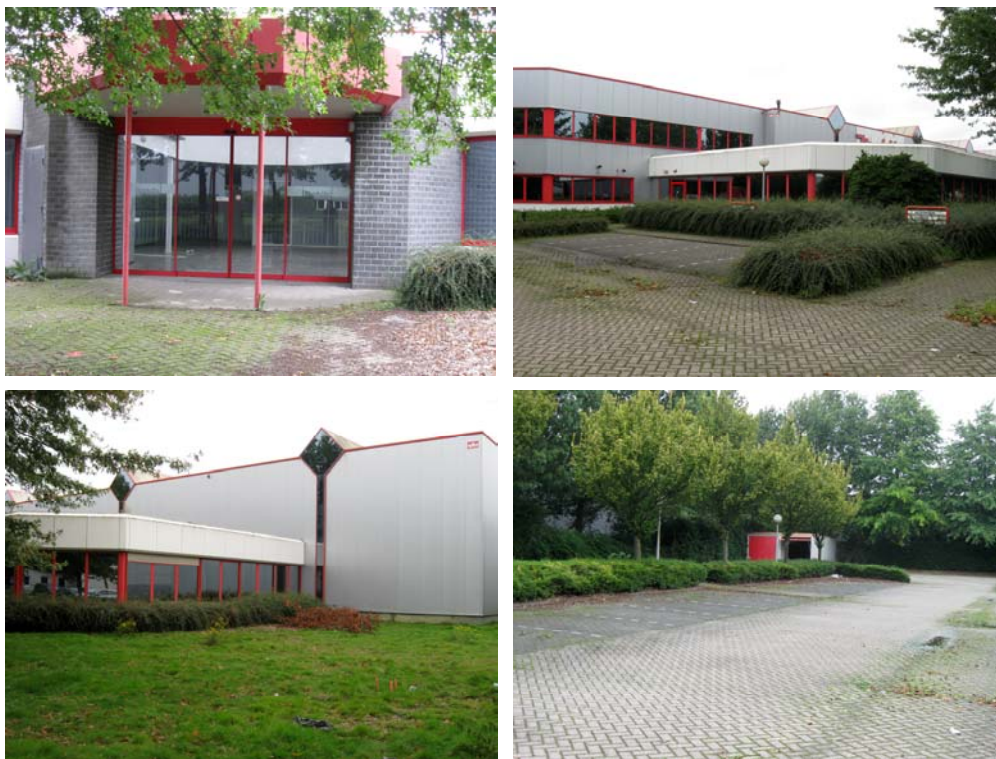
Figuur 2.1: Bestaande situatie
