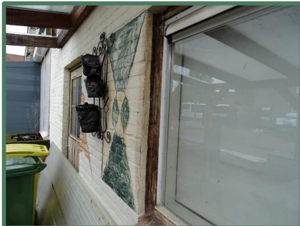
Strak aansluitende kozijn en deurpost
