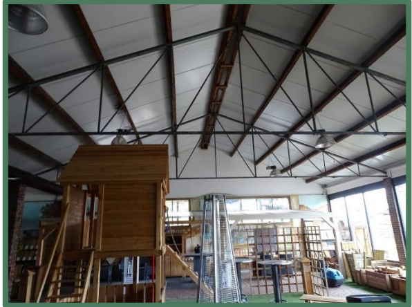
Binnenzijde loods met sandwichpanelen dak
