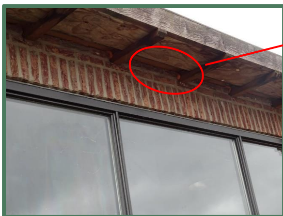
Strak gesloten rand tussen gevelbetimmering en wand
