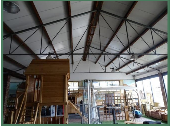
Binnenzijde loods met sandwichpanelen dak
