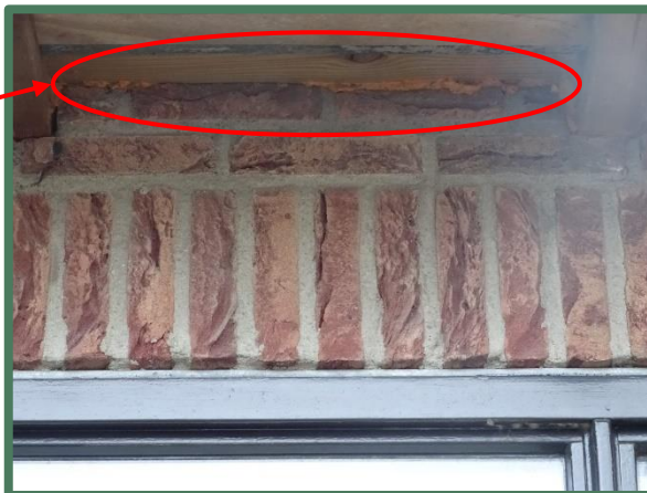
Strak gesloten rand tussen gevelbetimmering en wand
