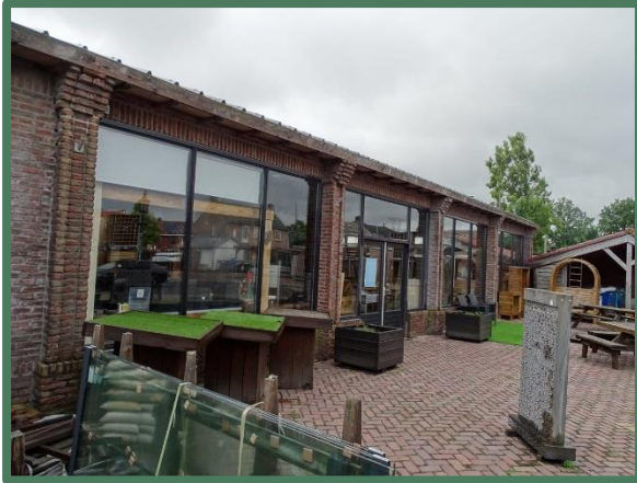
Loods met de vele ruiten
