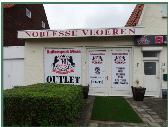
Deel van de winkel met het platte dak
