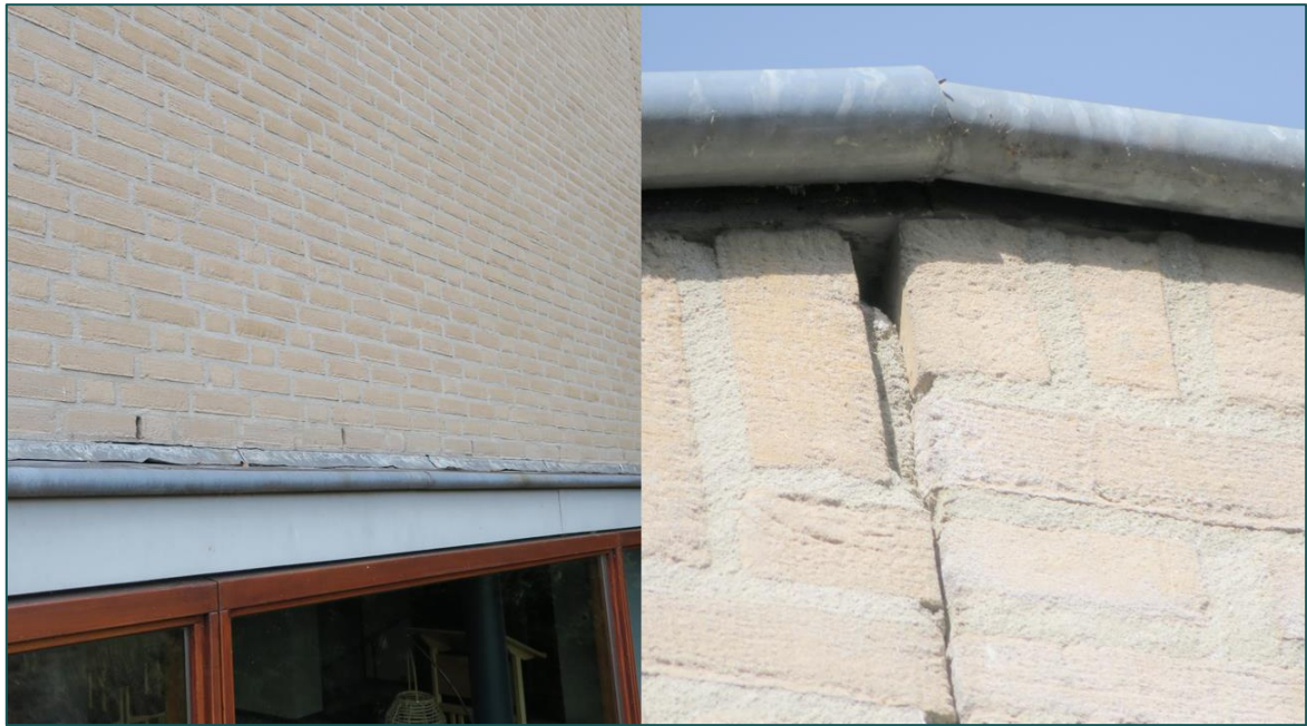
Figuur 3.1 In de bebouwing zijn er verschillende openingen aanwezig die naar potentiële verblijfplaatsen kunnen leiden. De openingen en de spouwmuur worden niet aangetast in de beoogde ontwikkeling.
