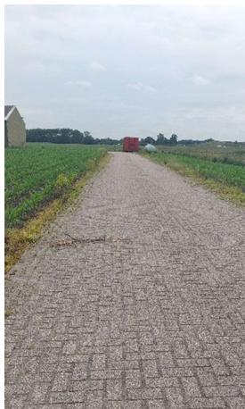
Fotonummer: 3 Omschrijving: Klinker verharde oprit.
