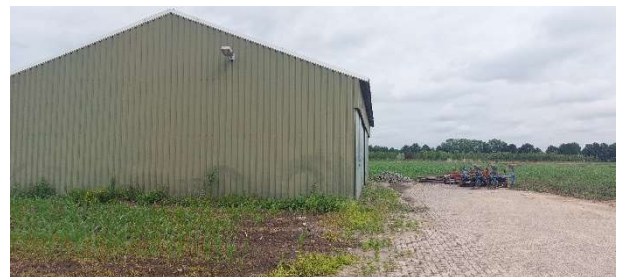
Fotonummer: 4 Omschrijving: Bestaande loods (opslag).
