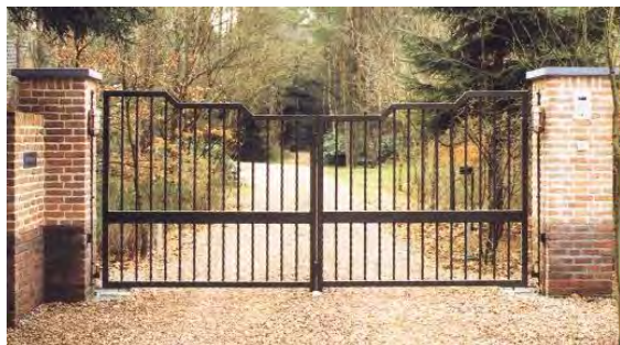
Eenvoudige, stalen of houten poort opgehangen aan twee gemetselde pilasters.
