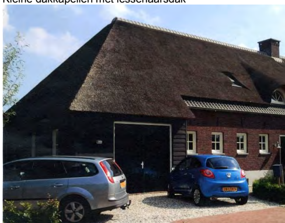
Rieten dak in combinatie met roodbruine baksteen. Deel van de gevel is betimmerd.
