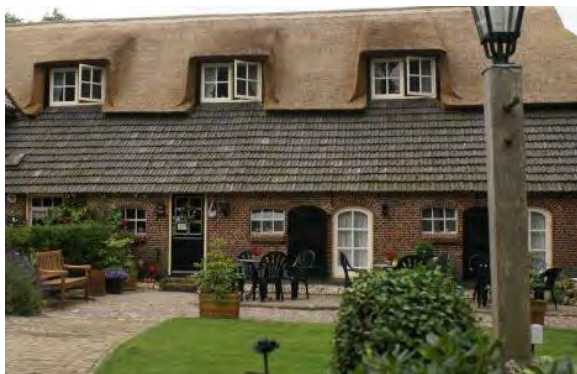
Materiaal gebruik gevel en dak. Kleine dakkapellen met lessenaarsdak
