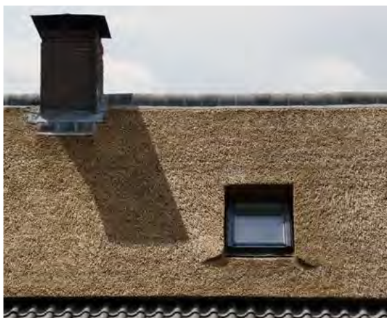
Rieten dak met dakraam
