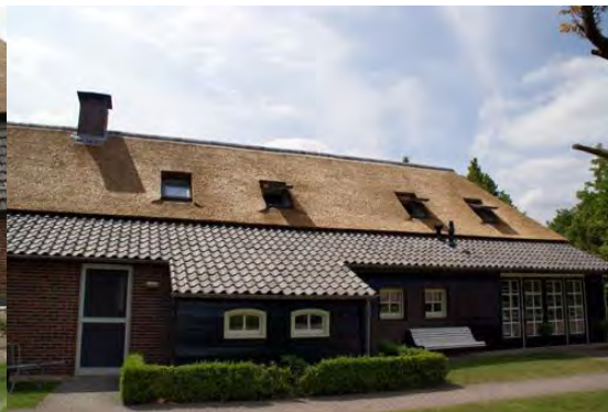
Rieten dak in combinatie met ongeglazuurde pannen. Een gedeelte van de gevel is betimmerd.
