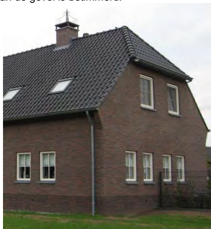
Plint in combinatie met rode stenen en pannen dak. Erfafscheidingen
