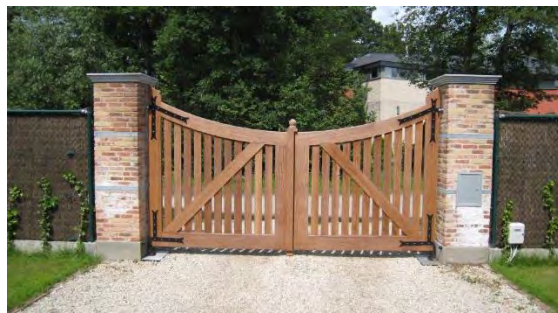
Eenvoudige, stalen of houten poort opgehangen aan twee gemetselde pilasters.
