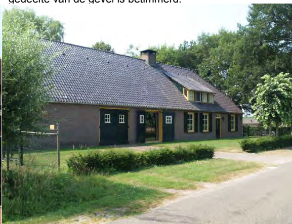
Ritmische verdeling van de ramen over de gevel.
