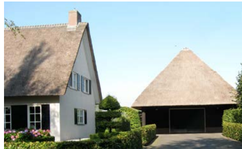
Bijgebouwen zijn vrijstaand en liggen achter de woning. Ze hebben een kap en zijn in detaillering en materiaalgebruik passend bij het hoofdgebouw.
