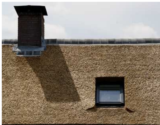
Rieten dak met dakraam
