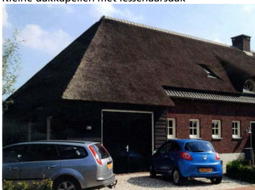
Rieten dak in combinatie met roodbruine baksteen. Deel van de gevel is betimmerd.
