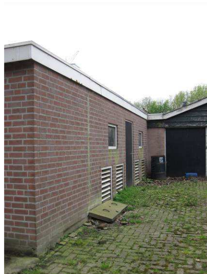
Boeiboord langs dakrand van te slopen stal.
