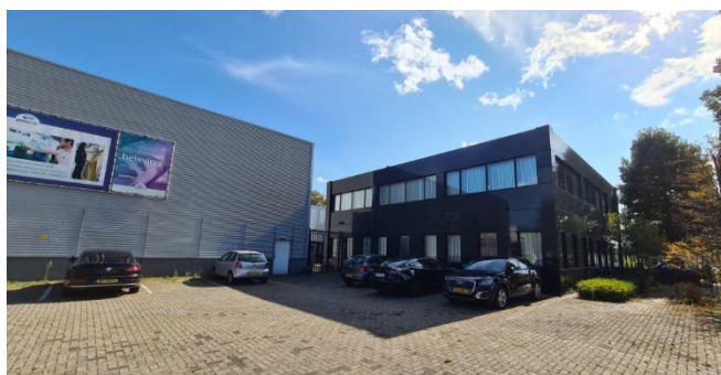
Figuur 7: Plangebied gezien vanuit het noordwesten
