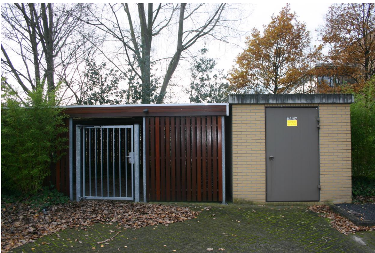
Figuur 5. Fietsenstalling en elektriciteitshuisje
