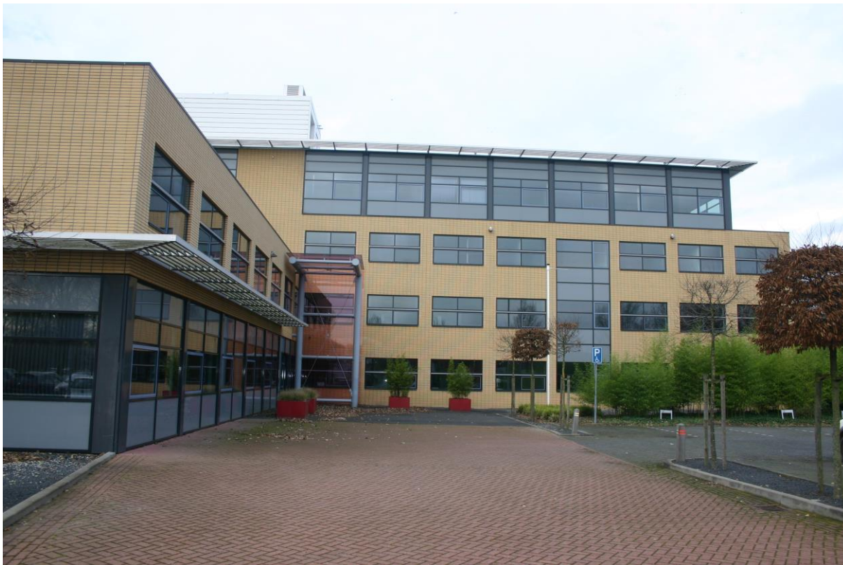
Figuur 2. Het hoofdgebouw, gezien vanuit het zuidoosten
