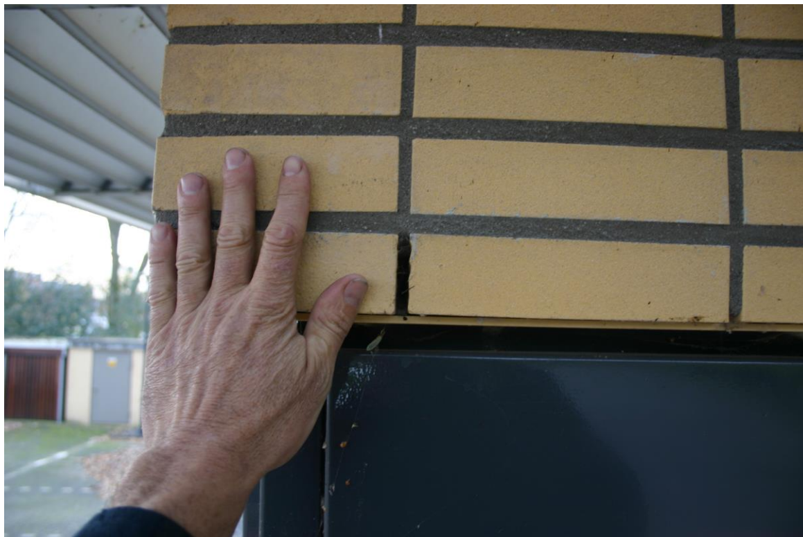
Figuur 6. De open stootvoegen in het hoofdgebouw zijn ongeschikt voor vleermuizen
