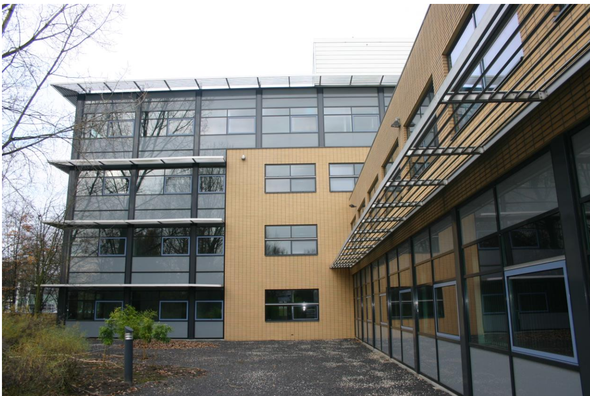
Figuur 3. De wanden van het hoofdgebouw zijn van glas en tegelstrips
