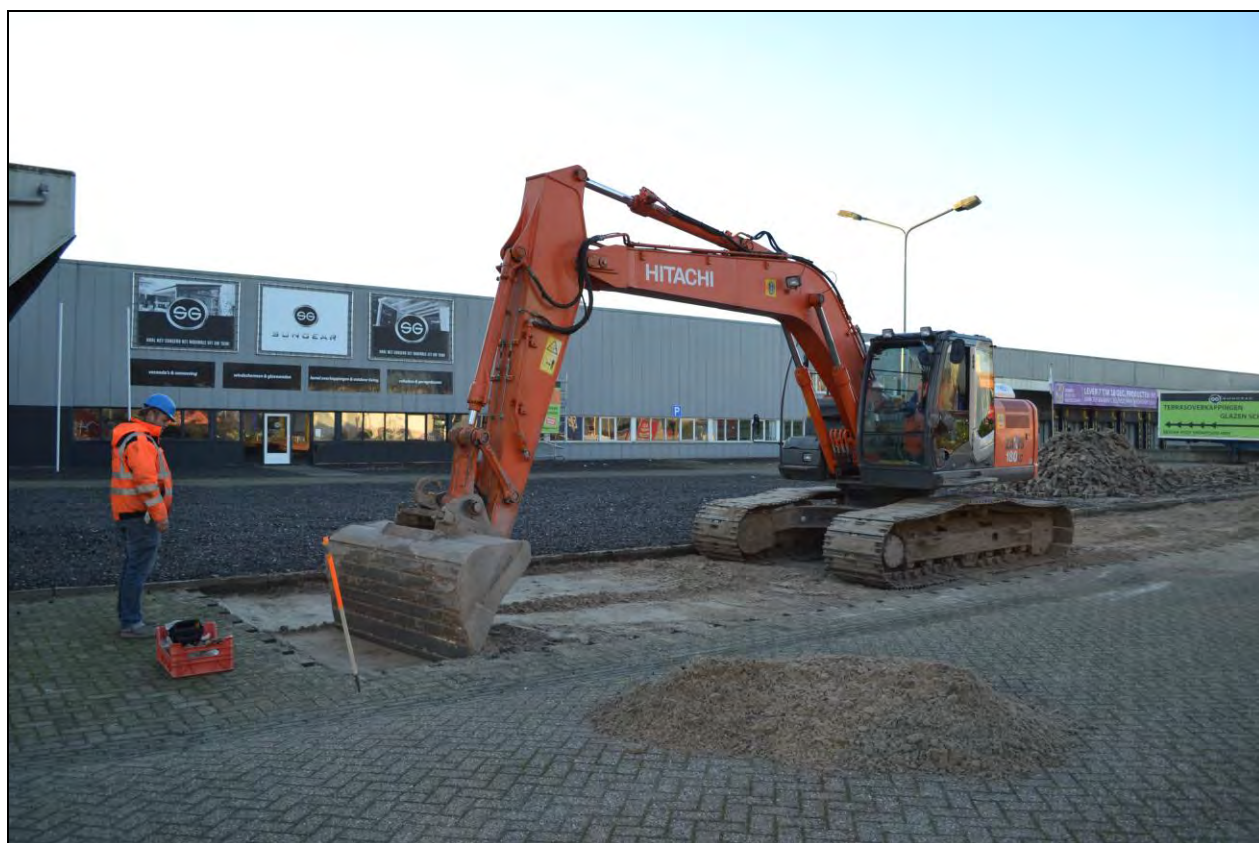
Figuur 2: Aanleg van werkput 1 na verwijdering van de klinkers.
