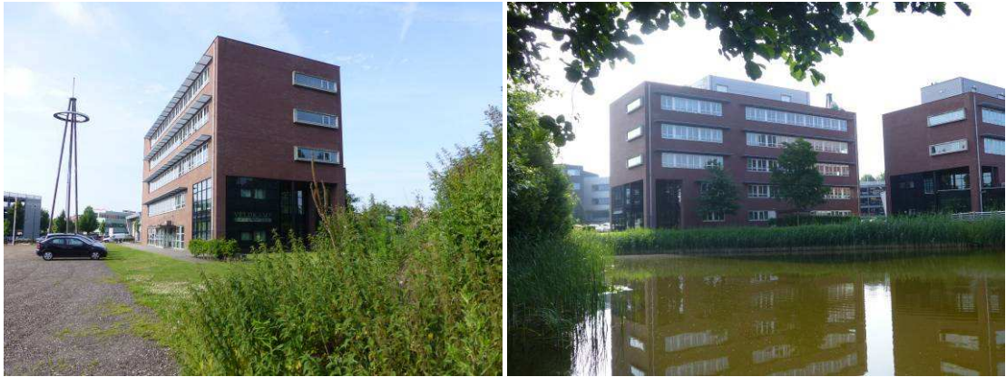
Afbeelding 5.2. Gebouwen rondom de vijver in het plangebied.
