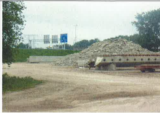
Foto 1: Betonopslag noordwestelijk terrein
