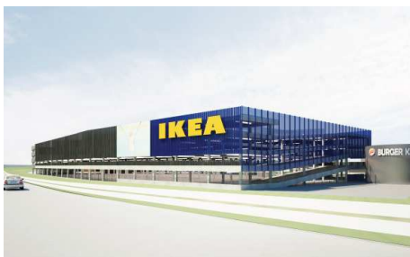
Impressies, vanaf A50 (links) en A58 (rechts) (Bron: Knevel Architecten, 2010)
