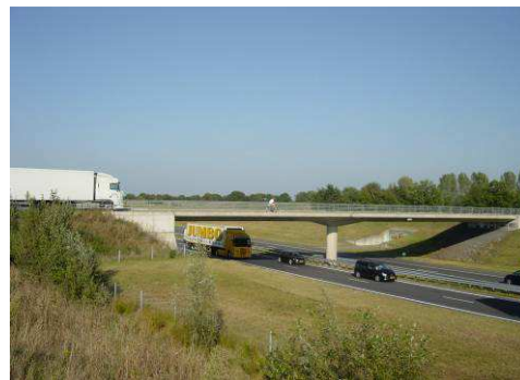
Viaduct Sonniuswijk (nummer 9 op de afbeelding situatie A50 anno 2009)
