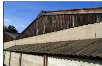
Figuur 14. Achterzijde van schuren aan de zuidkant van het plangebied.
