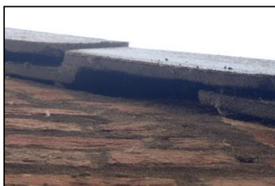
Figuur 17. Overhangende dakpannen
