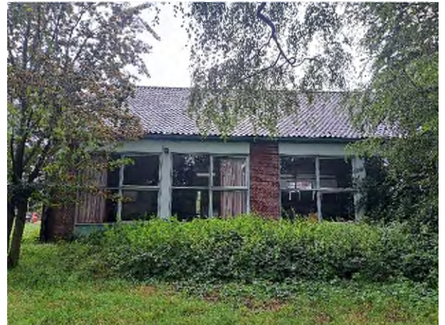
Fotonummer: 4 Omschrijving: Achterzijde Sint Genovevastraat 37
