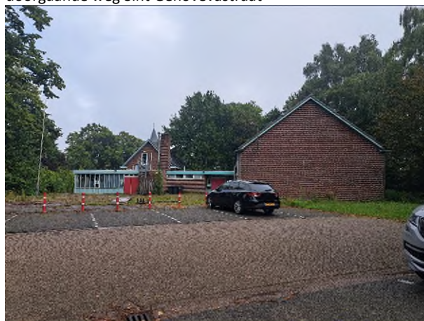
Fotonummer: 16 Omschrijving: Parkeerplaats Sint Genovevastraat 37
