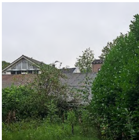
Fotonummer: 10 Omschrijving: Achterzijde pand Pieter Brueghelplein 1b
