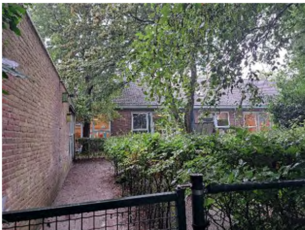
Fotonummer: 5 Omschrijving: Achterzijde Sint Genovevastraat 35
