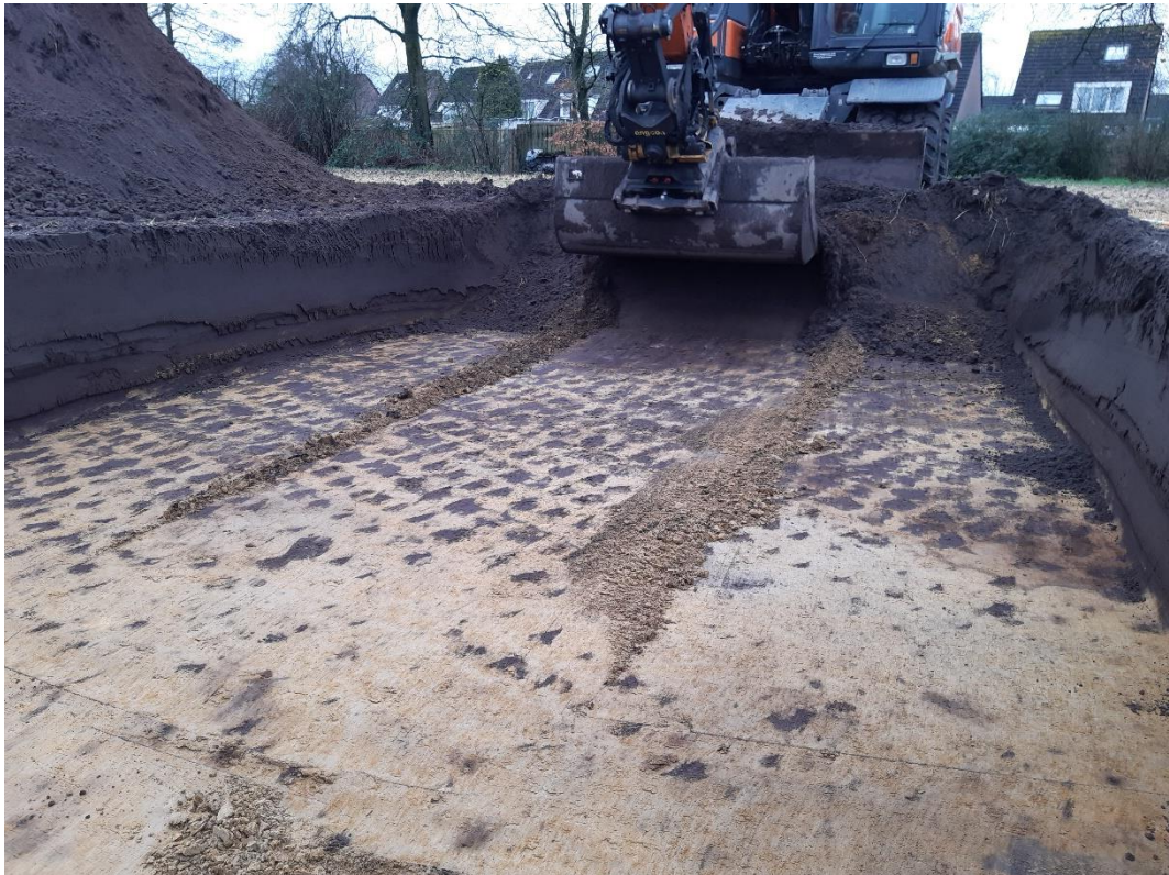
Afbeelding 29. Spitsporen bij de aanleg van WP06. Foto genomen vanuit het noordoosten.
