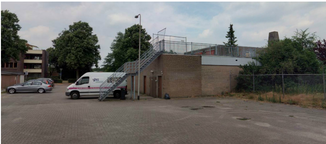
Achterzijde bedrijfspand gezien van het parkeerplein
