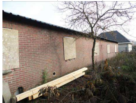
Impressie te slopen schuur achterkant
