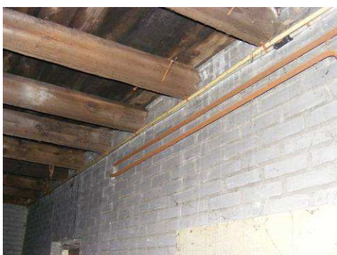
Foto 1: Binnenruimte in de schuur.
