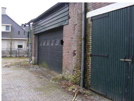
Buitenmuur aan de noordkant
