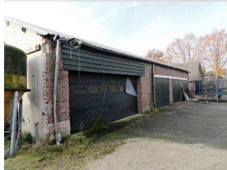
Impressie te slopen schuur zijkant
