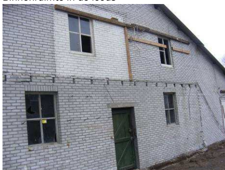
Buitenmuur aan de westkant
