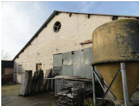
Impressie te slopen schuur achterzijde
