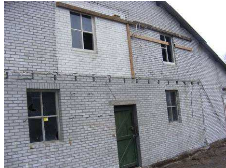
Buitenmuur aan de westkant
