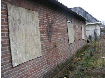
Buitenmuur aan de zuidkant
