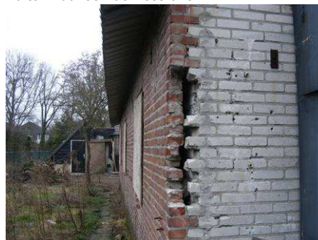
Buitenmuur aan de zuidkant
