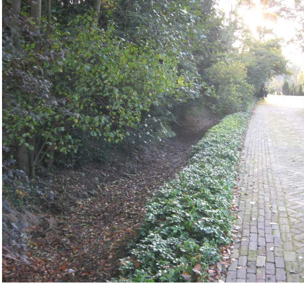
Figuur 19. Sloot ten behoeve van de opvang van hemelwater
