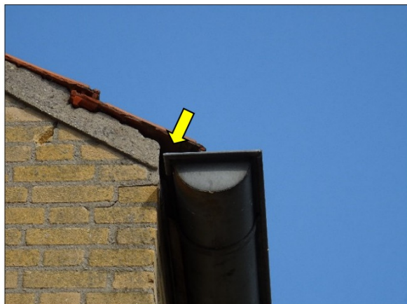
Figuur 5.1 Ruimte tussen dakgoot en dakpannen geschikt voor huisvuismussen en gierzwaluwen.
