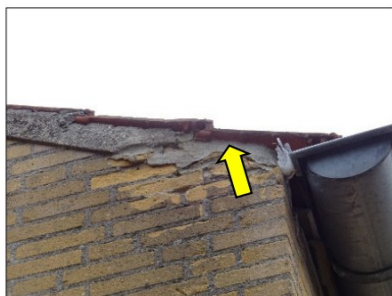
Figuur 5.4 Ruimte onder de dakpannen waar vleermuizen gebruik van kunnen maken.
