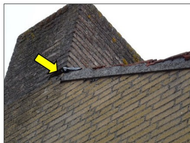
Figuur 5.5 Ruimte onder de dakpannen waar vleermuizen gebruik van kunnen maken.
