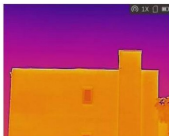
Figuur 5a: Warmtebeeld gevel
