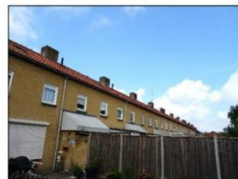
Figuur 2.5 Impressie achterzijde huizenblok op onderzoekslocatie.
