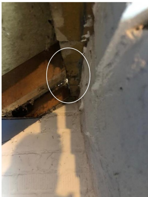
Figuur 18a: Opening dakbeschot naast schoorsteen.
