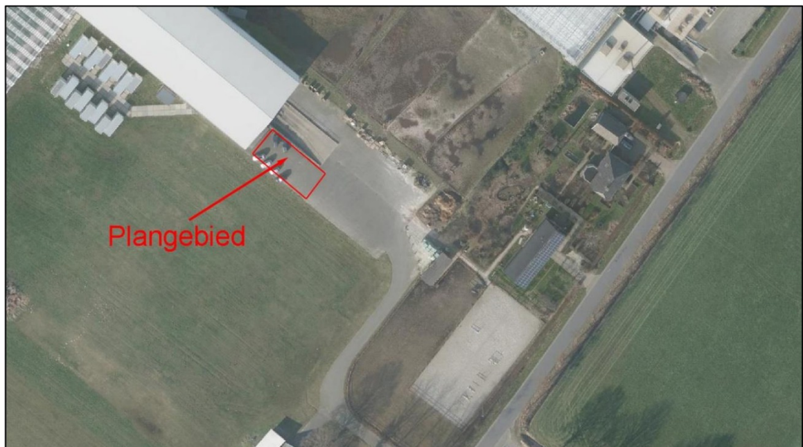
Luchtfoto huidige situatie
