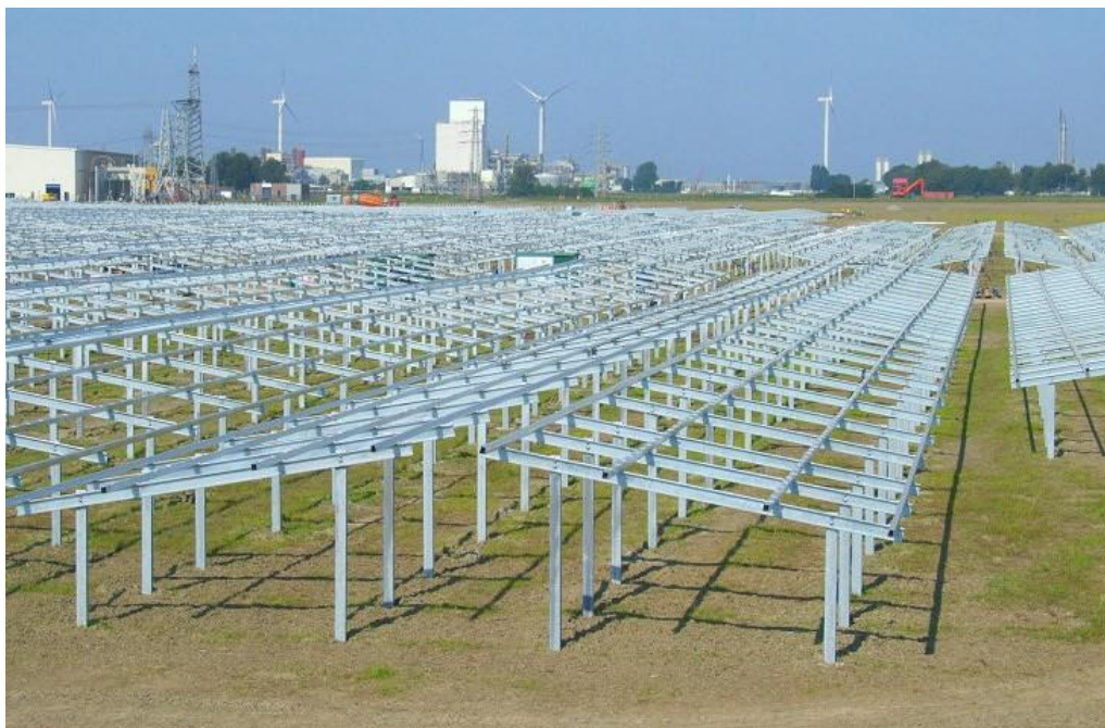
Figuur 4.2 Foto ter illustratie van installatieframe voor bevestiging zonnepanelen
