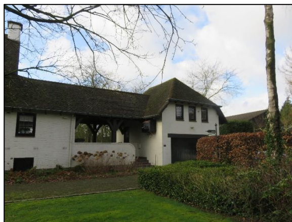
Foto 6. Westzijde van de woning
