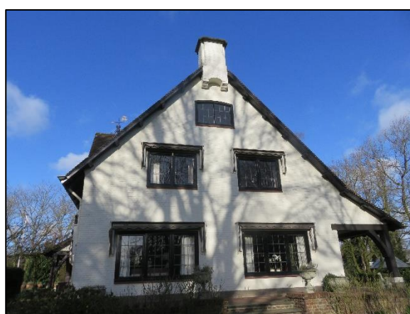
Foto 4. Oostgevel van de woning
