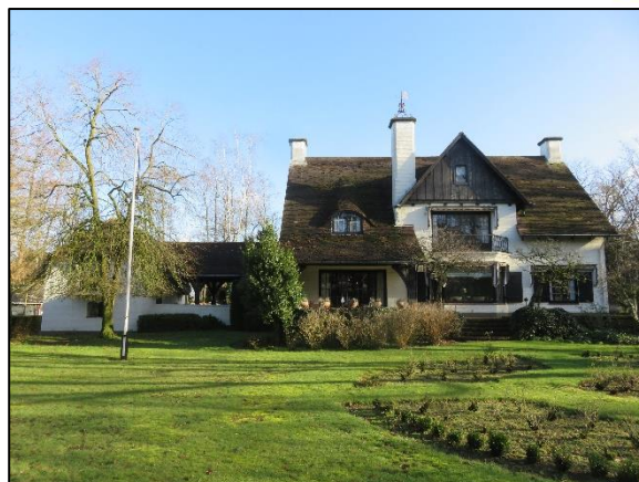
Foto 2. Voorgevel van de woning
