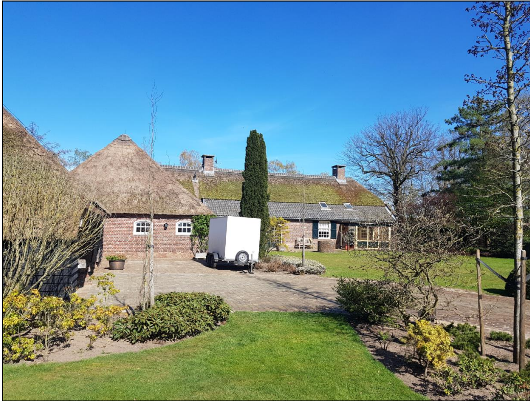
Figuur 7: Achterzijde woonboerderij met aanbouw en daarachter de garage
