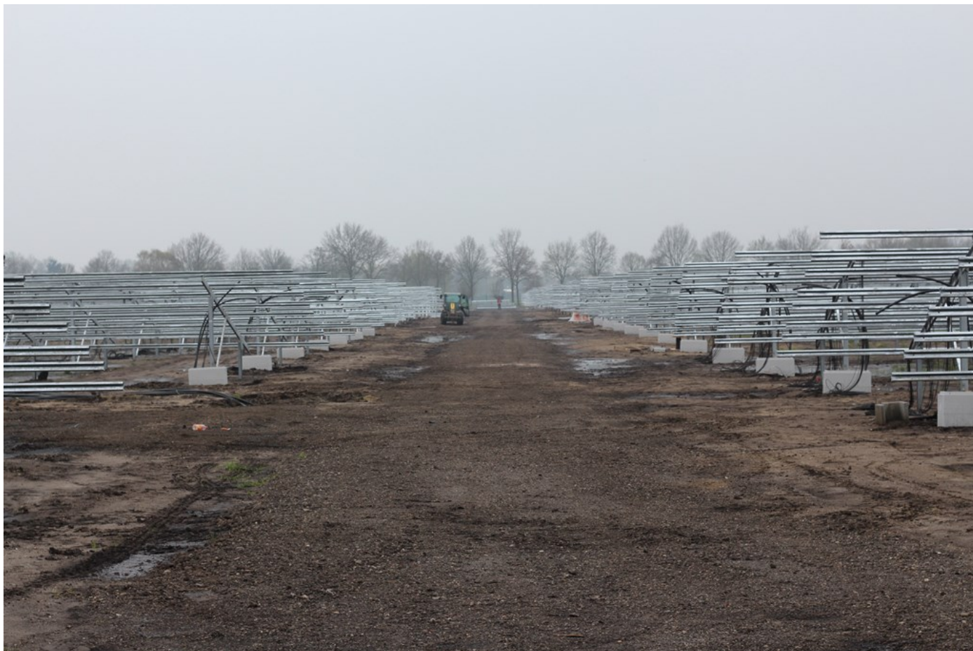
Figuur 10. De middenweg gevormd door asfalt granulaat, noodzakelijk voor onderhoud aan de panelen. De weg is echter zo breed dat men zich kan afvragen of dit echt nodig is. Er liggen hier kansen om het kruidenrijk grasland langs de randen of stapsteensgewijs door te voeren. Ook kan worden overwogen om twee poelen te realiseren en/of een smalle sloot (bijvoorbeeld in het midden) met een rijkelijk begroeide oever gedomineerd door grote ratelaar (zie tekstbox).
