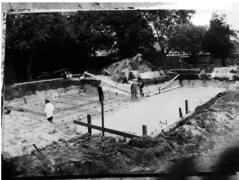
Op de foto is te zien dat eerder al buiten de keldermuren om nog eens 2 meter is uitgegraven. Dit geldt ook voor appartementencomplex hoek Postelstraat/Melchertstraat
