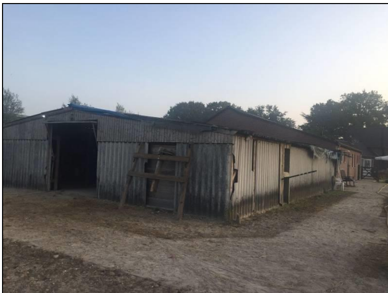
Figuur 5: Foto te slopen stal
