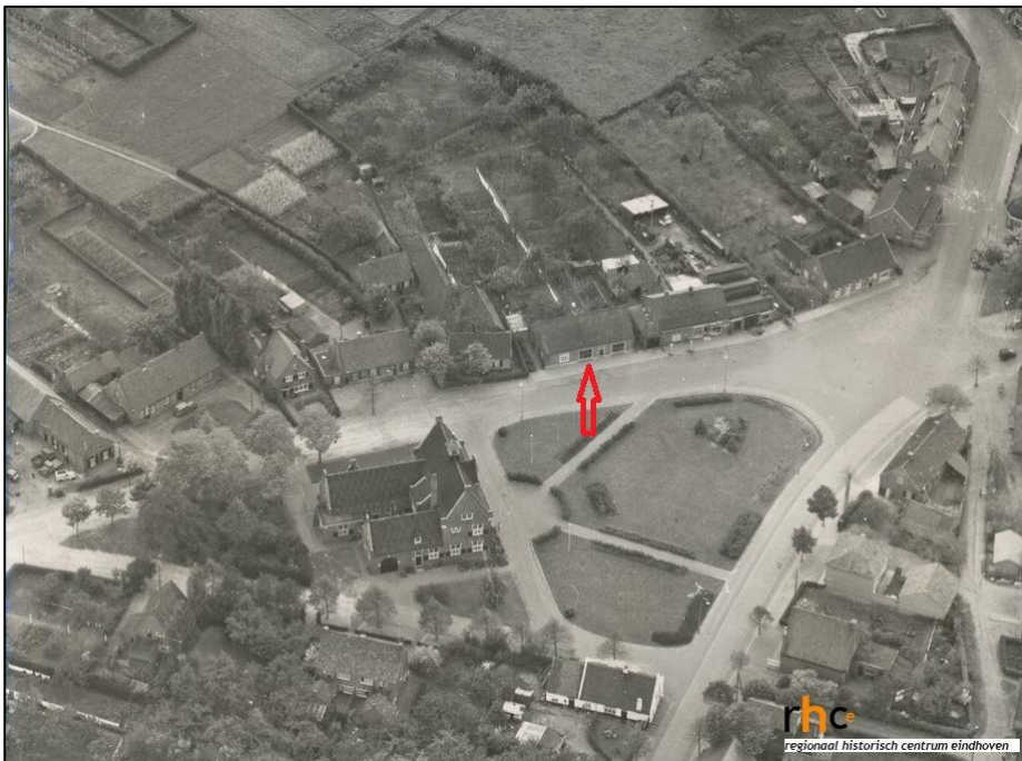
Figuur 2.7 De boerderij van Maas op een luchtfoto uit de zomer van 1952 (bij rode pijl). Te zien is dat het achterterrein niet bebouwd was. Er stonden enkele bomen. ( http://www.rhc-eindhoven.nl fotonummer 237614).
