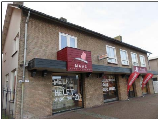
Foto 1. Te slopen pand
