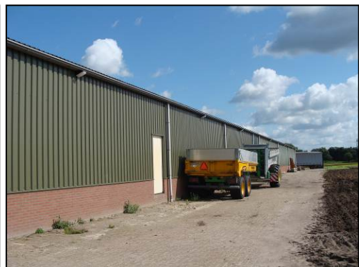
Foto 4. Achterzijde bestaande loods
