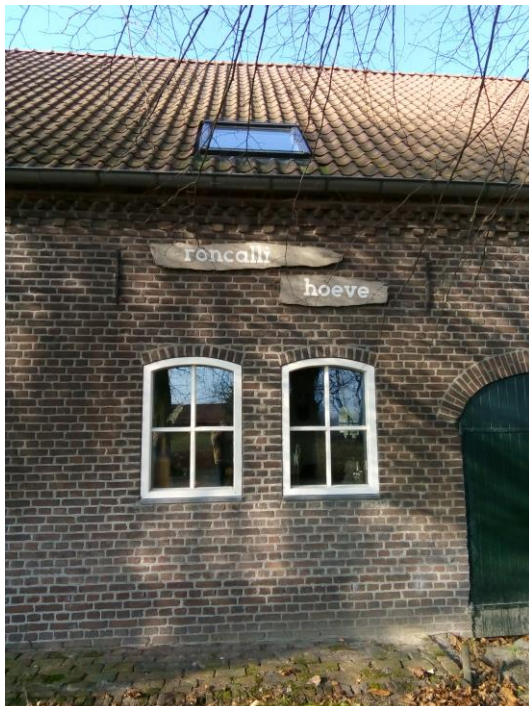
26. Twee stuks nieuw ingebrachte stalramen aan de voorgevel en nieuw raampje in de noordelijke kopgevel.
