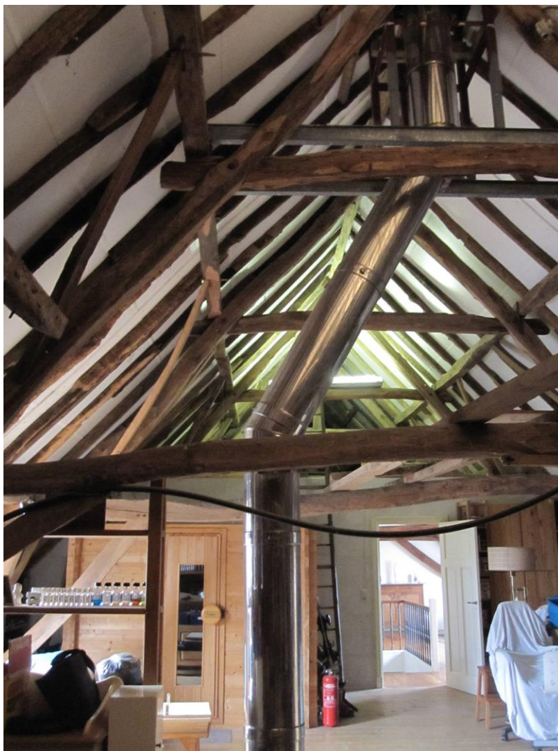
36. Kapconstructie boven het noordelijk deel gezien naar het opnieuw ingedeelde zuidelijk deel van de zolderverdieping.
