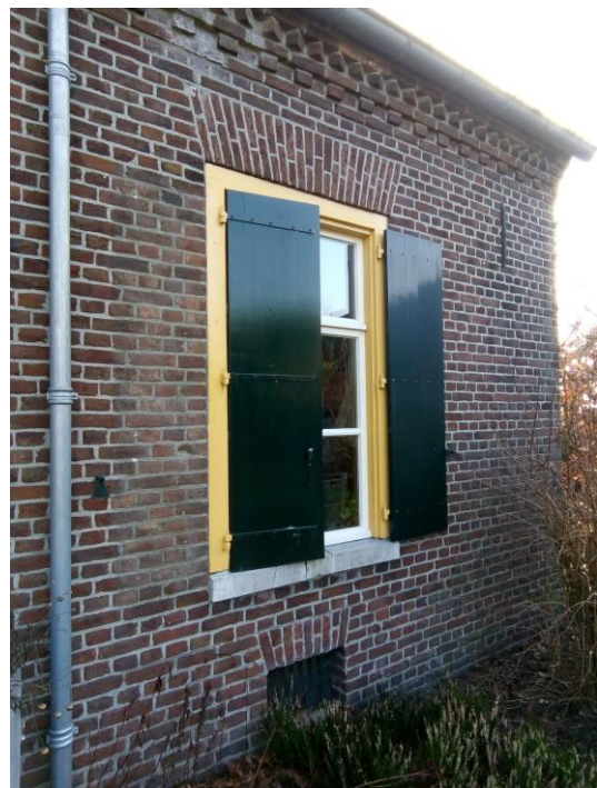
29. Gewijzigde terrasdeur in de gevel van het woongedeelte aan de achtergevel en oorspronkelijk venster met kelderlicht aan de achtergevel.
