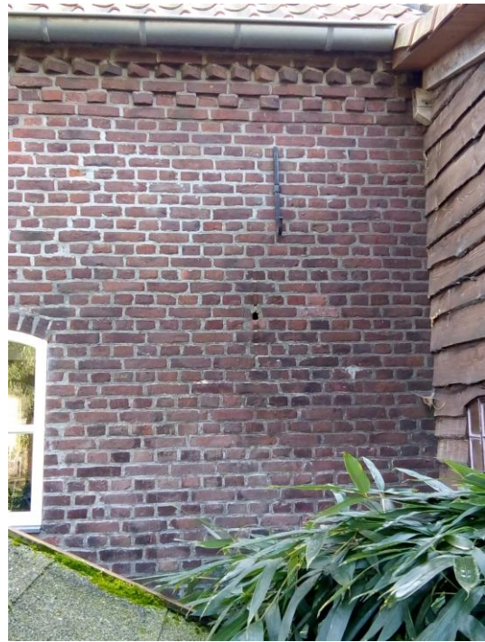
27. Nieuwe terrasdeur in de gevel van de voormalige schuur aan de achtergevel en een verhoogd aangebracht muuranker aan de achtergevel.
