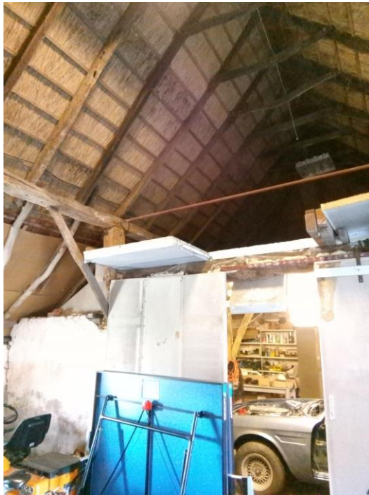
44. Gebint en kapconstructie gezien naar het tot garage ingerichte deel van de schuur.
