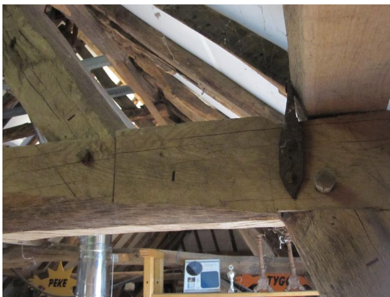
37. Detail jukdekbalk met telmerken, toognagels en gesmede strop van de jukplaat.
