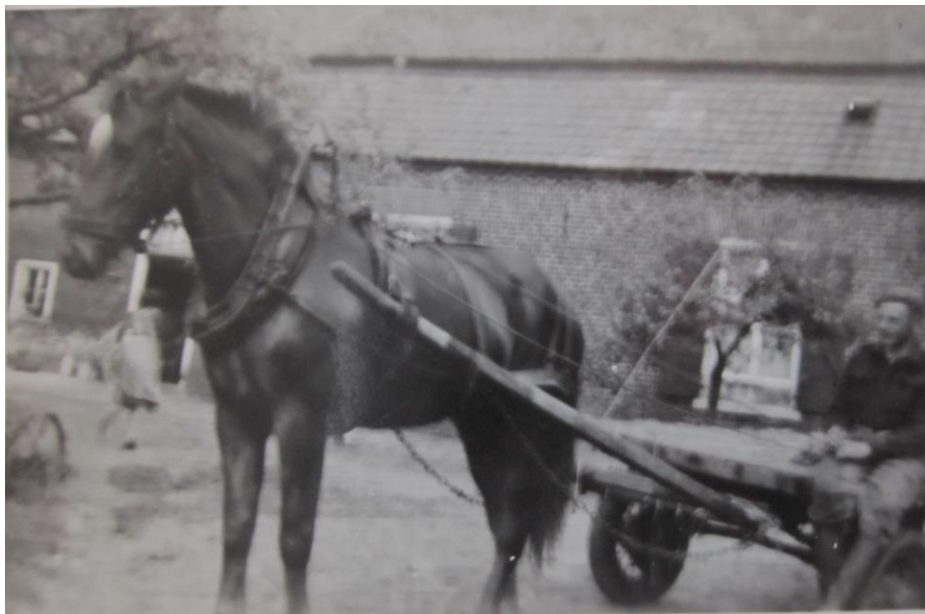
23. Foto mei 1950; achtergevel ter hoogte van het woongedeelte.
