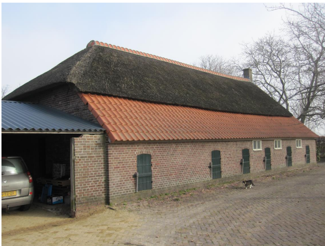
42. Schuur gezien vanuit de zuidwestkant.
