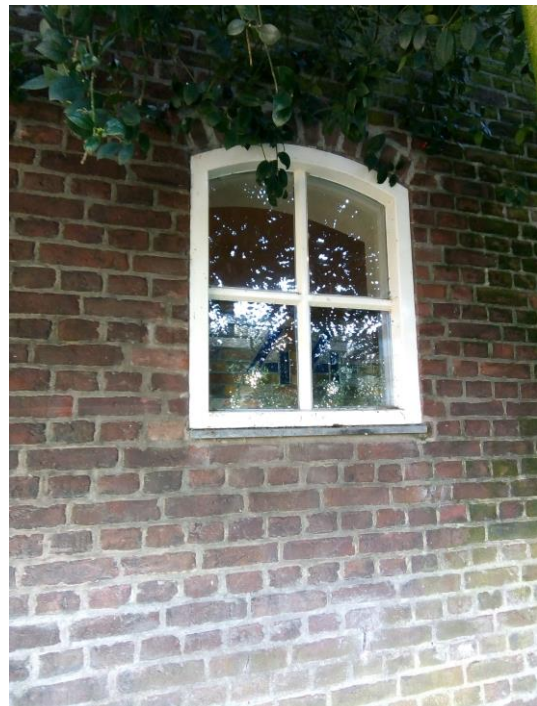
26. Twee stuks nieuw ingebrachte stalramen aan de voorgevel en nieuw raampje in de noordelijke kopgevel.
