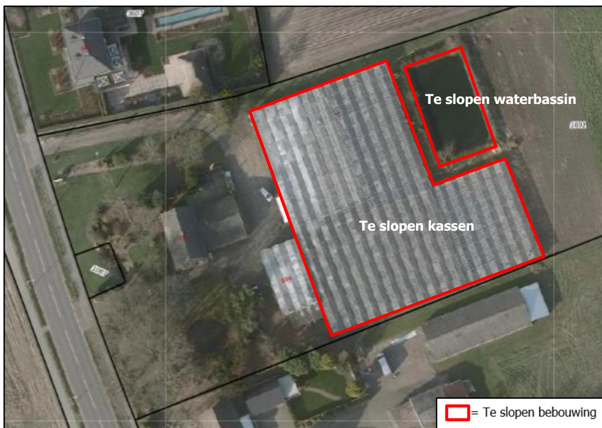
Afbeelding 1: Te slopen bebouwing Boerenkamplaan 69 Someren
