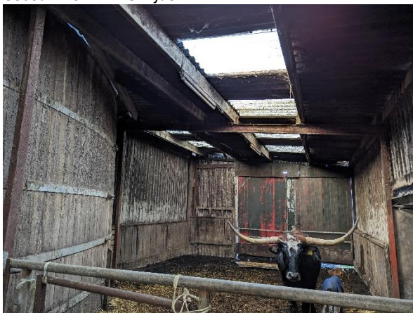
Gebouw no.8 Binnenzijde
