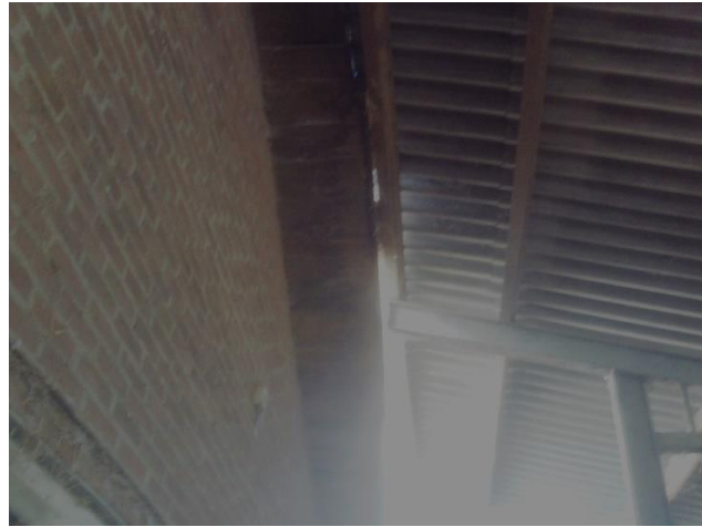
Zicht op de bekisting
