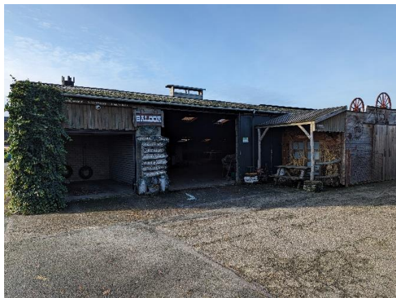
Gebouw no.2 buitenkant oostzijde
