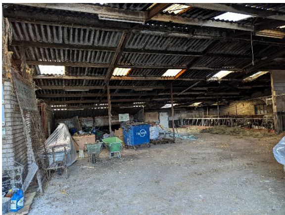
Gebouw no.2 Binnenzijde
