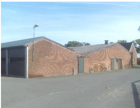
Links gebouw 5 (opslag); rechts gebouw 2 (veestal)
