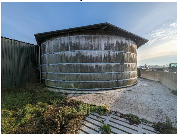
Gebouw no.9 Buitenkant
