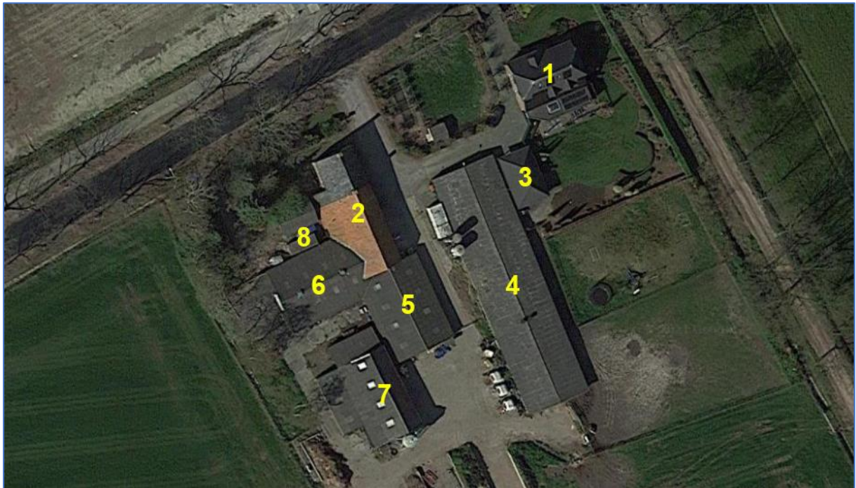
Figuur 1: Plattegrond van de huidige situatie met daarop met cijfers de bestaande bebouwing van de rundveehouderij weergegeven
