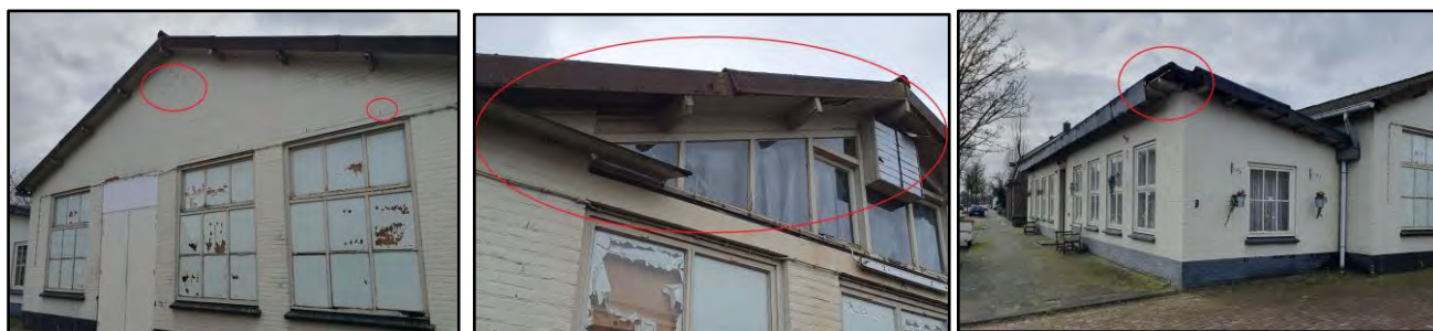
Potentiële vleermuisverblijfplaatsen in de te slopen bebouwing.
