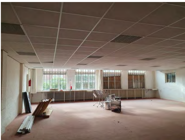
De binnenzijde van de te slopen bebouwing.
