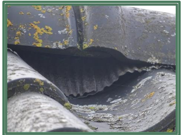
Afgesloten nok van loods met vogelschroot
