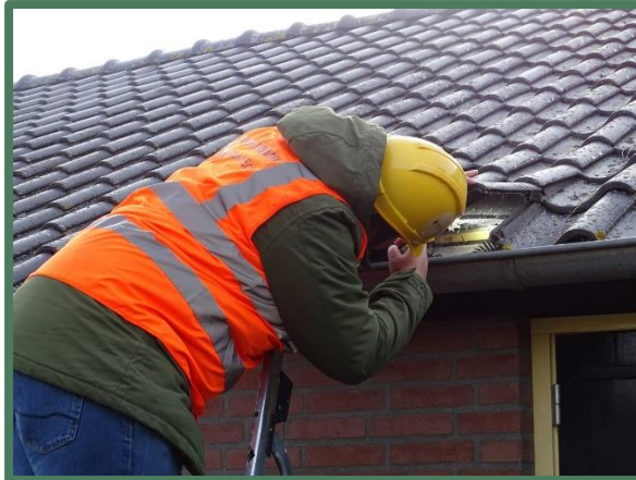
Controle vogelschroot onder dakpannen
