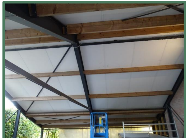
Aanbouw van de loods
