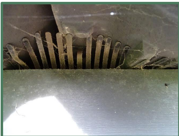
Afgesloten dak van loods met vogelschroot
