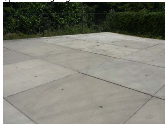
Oostelijke verharding stelcon
