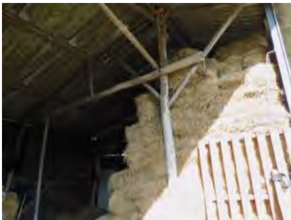
Binnenzijde te slopen loods
