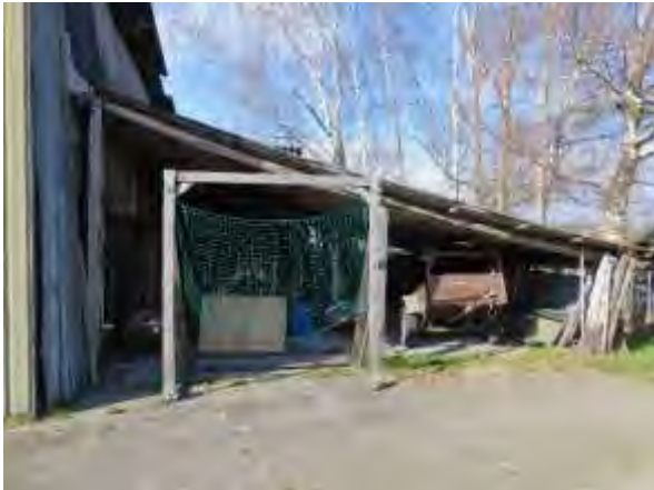
Te slopen overkapping
