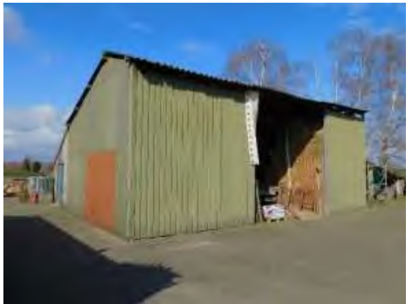
Te slopen loods met veevoer opslag
