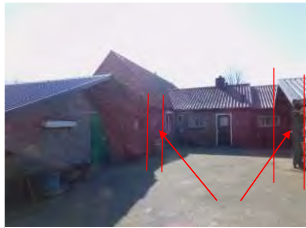
Achterzijde woning met aanbouw. De te slopen overkappingen/aanbouw zijn aangegeven met een rode pijl
