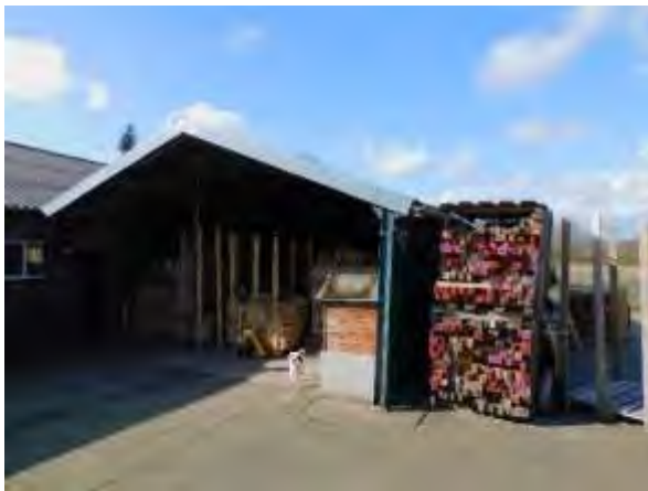
Te slopen aanbouw
